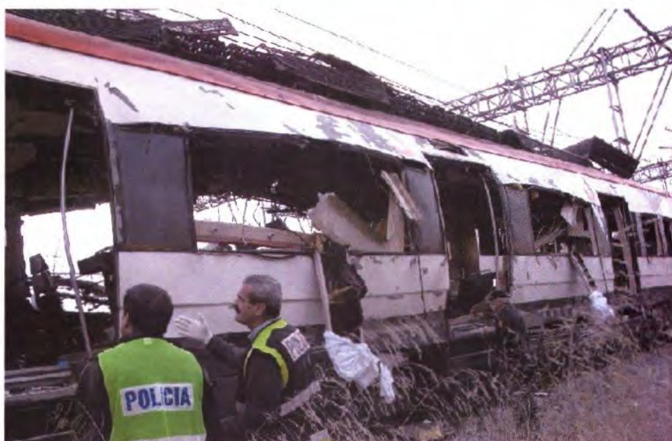
VISTAS DE LOS EFECTOS DE LA EXPLOSIÓN EN AMBOS COSTADOS DEL VAGÓN
